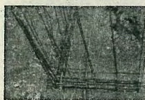
Noeud de chaînage - Continuité mécanique
