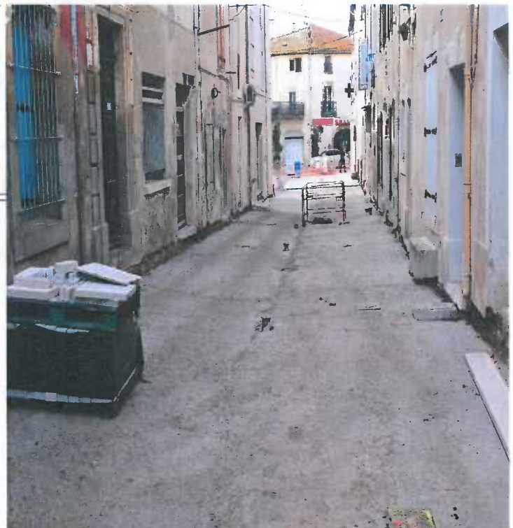
Rue de l'Hôtel de ville en travaux
